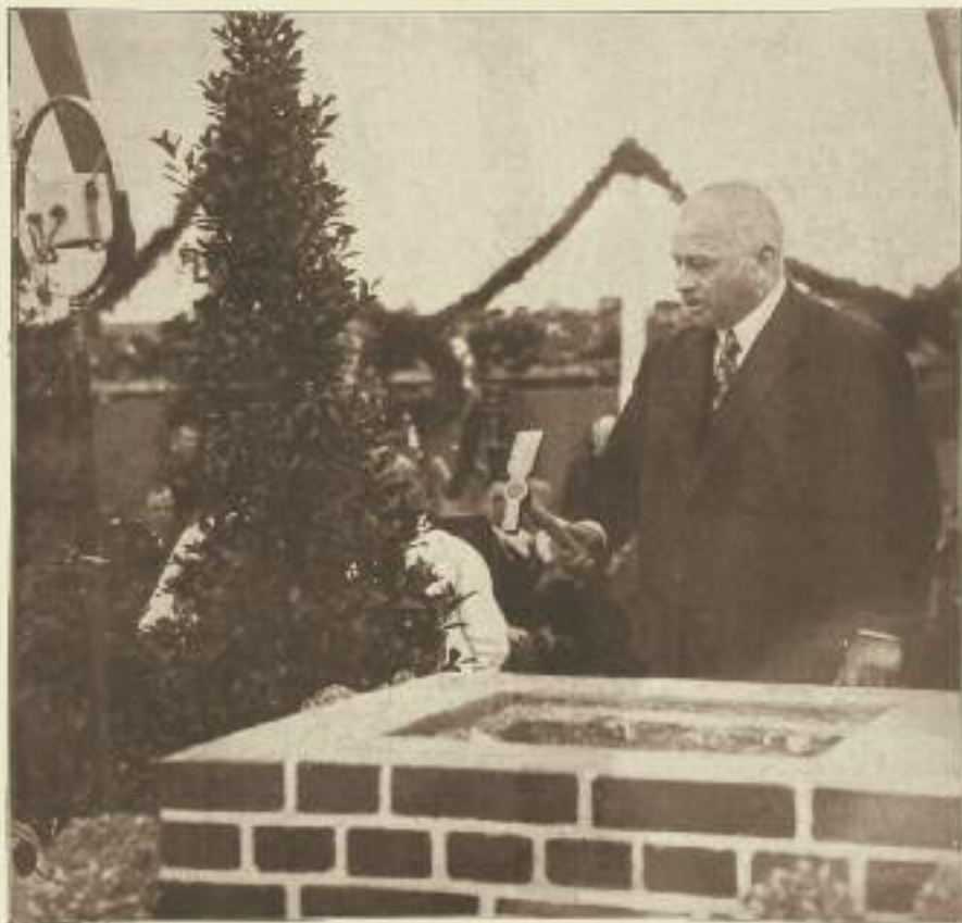
Die Grundsteinlegung des neuen Berliner Funkhauses
